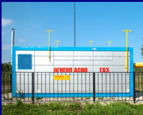
ГАЗОРАСПРЕДЕЛИТЕЛЬНАЯ ПОДСТАНЦИЯ ГРПБ
